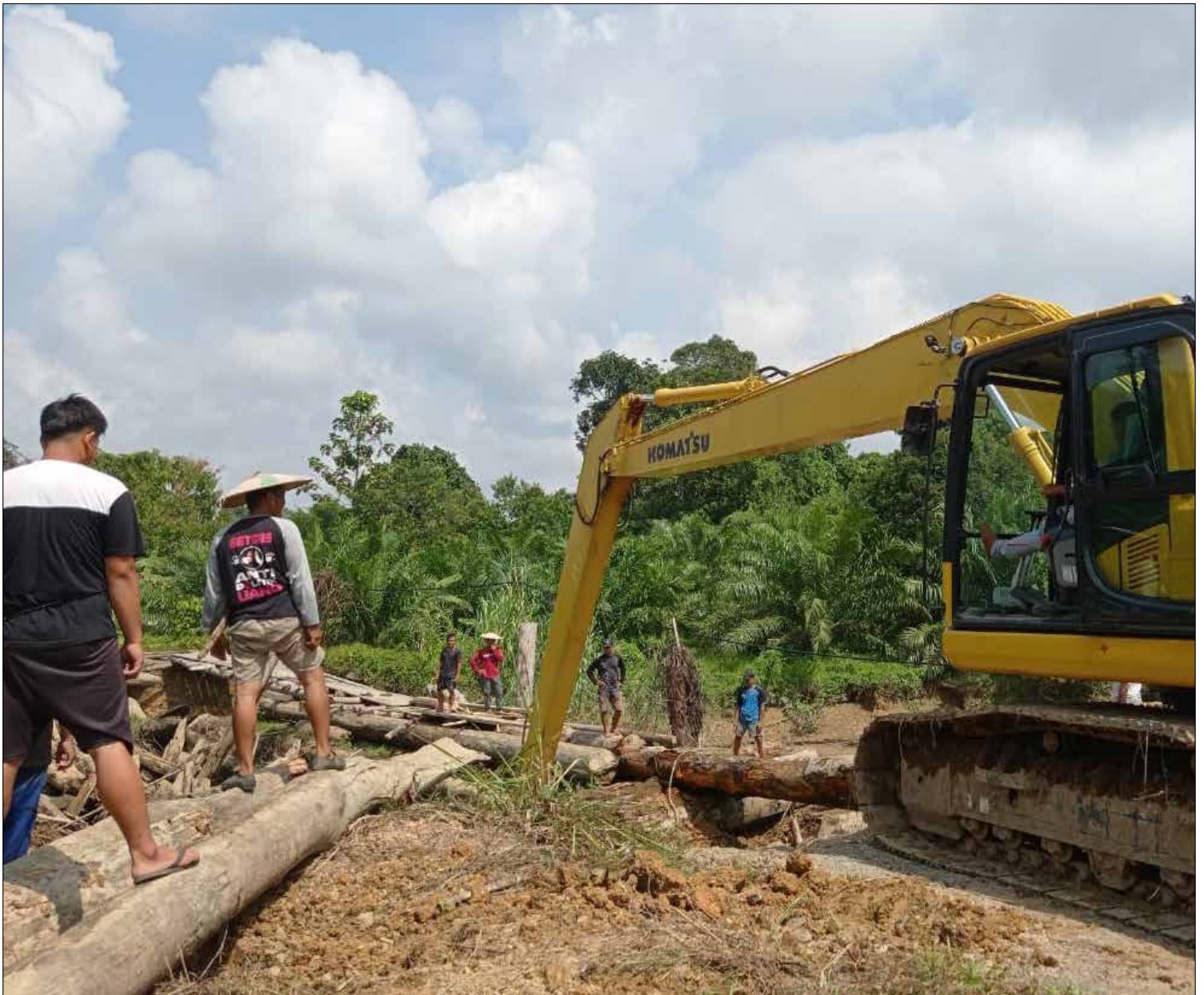
Jembatan Sei Seputuk dilakukan perbaikan oleh Pemkab Tana Tidung.
