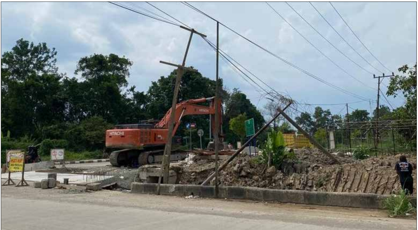
Pembangunan drainase di Jalan Diponegoro Kecamatan Tanjung Redeb.
