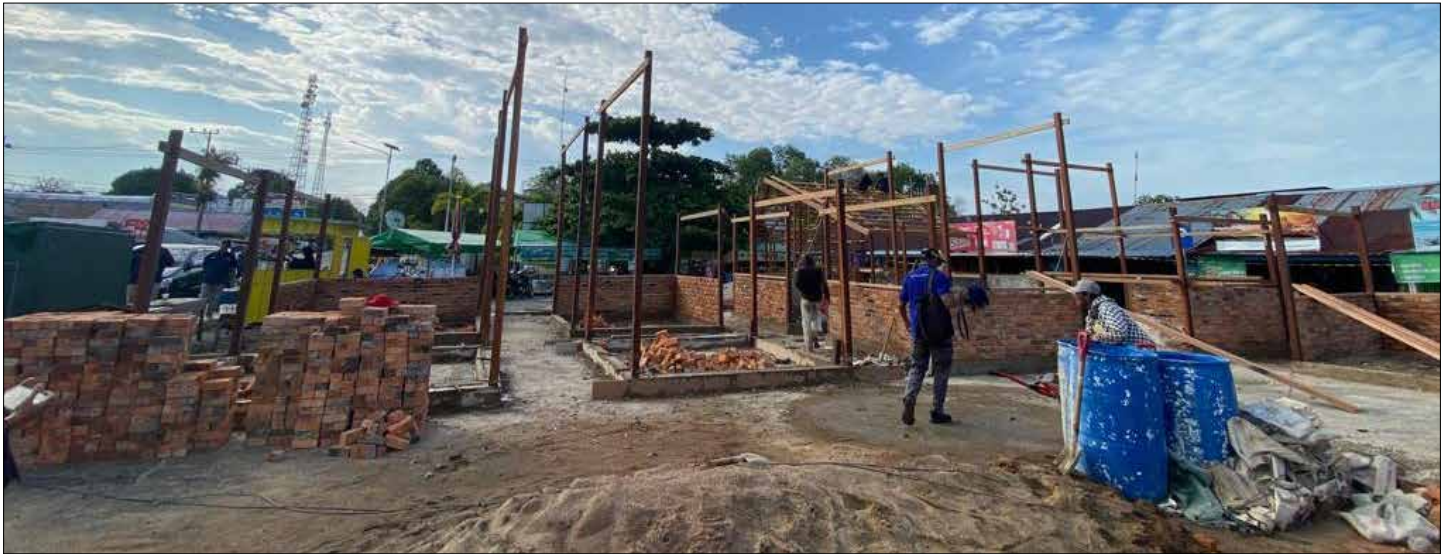
Pembangunan kios cindramata di halaman parkir Pelabuhan Sidayang Kampung Tanjung Batu Kecamatan Pulau Derawan.
