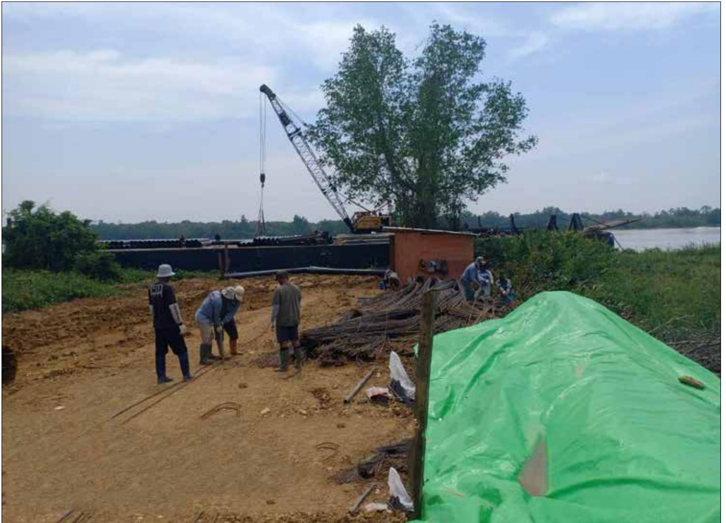
Material pembangunan orpit Jembatan Salimbat, sebagian sudah tiba di lokasi.
