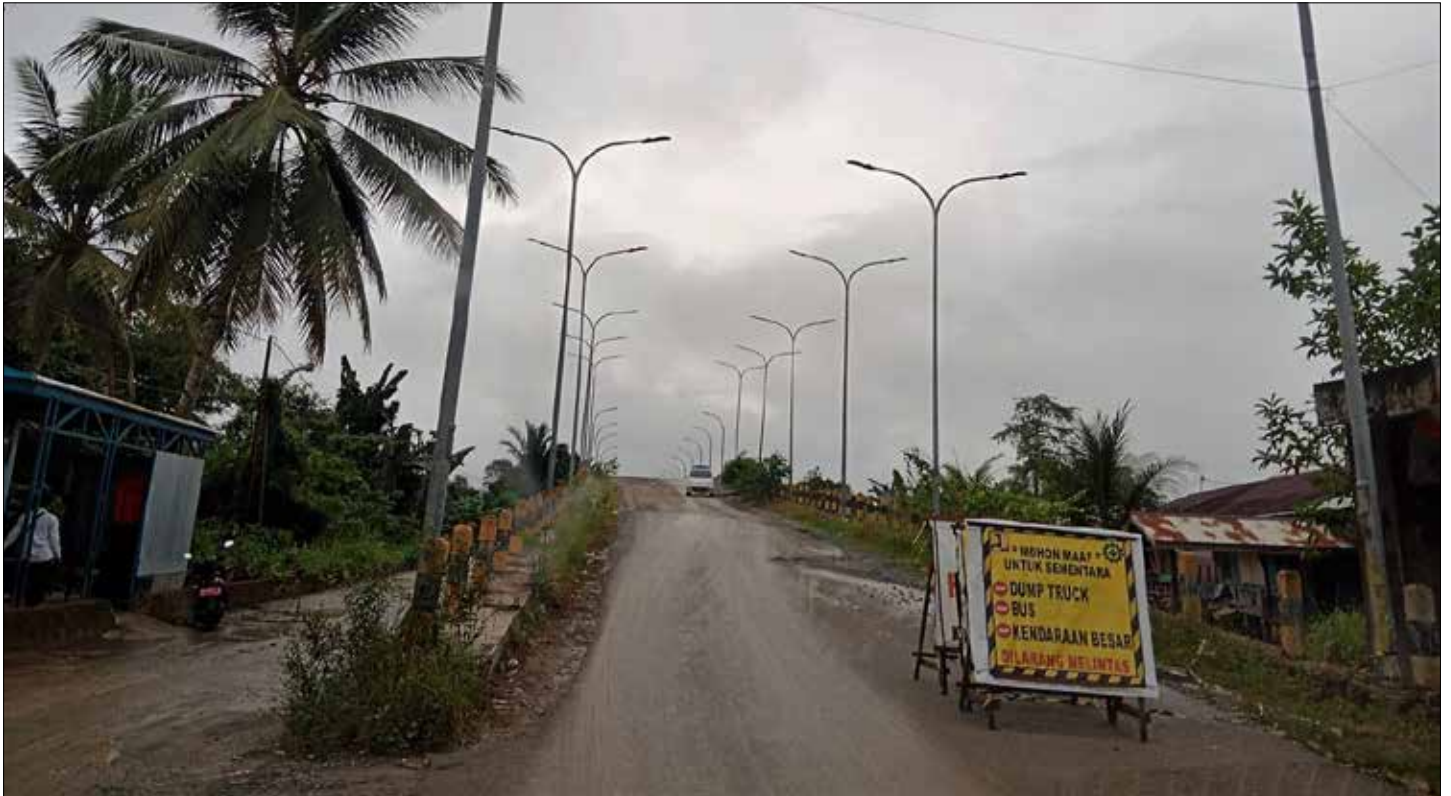
Jalan Bulu Perindu tahun ini dilanjutkan pengerjaan dengan luas jalan 900 meter.
