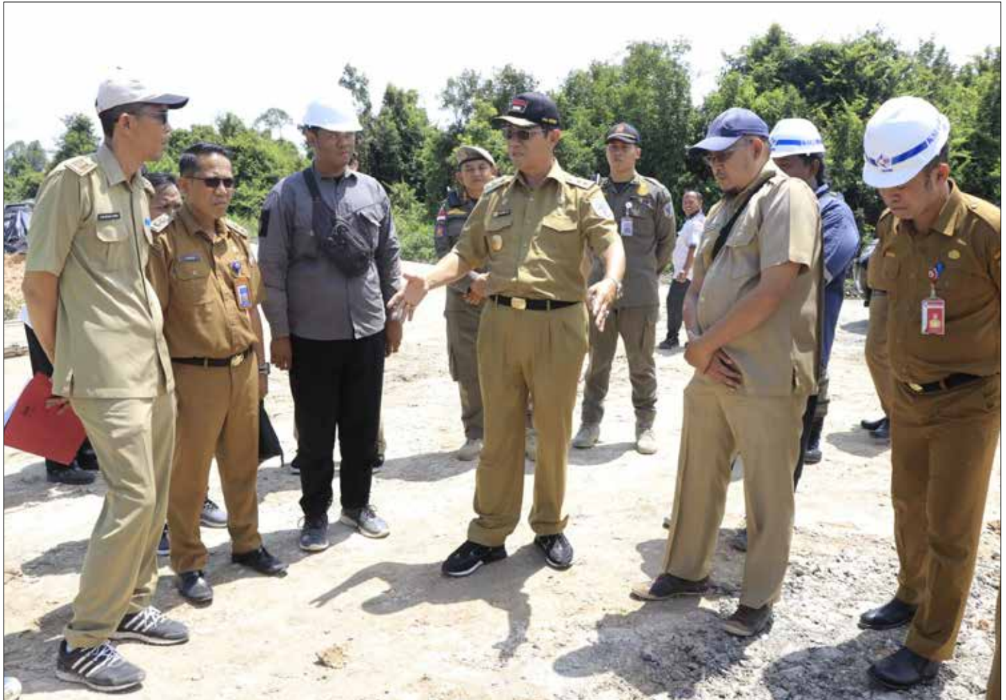
KUNJUNGAN LAPANGAN: Wagub Kaltara, Dr Yansen TP, M.Si meninjau pembangunan Gedung Diklat yang dibangun di KBM Tanjung Selor, Selasa (12/9) lalu.
